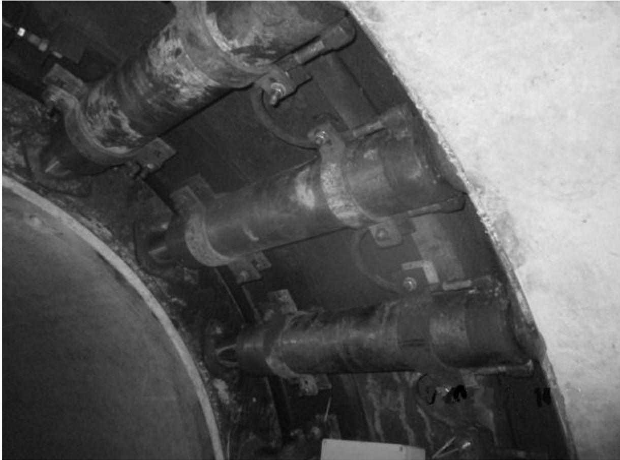
Abbildung 8: Dehnerstation DN 2200
