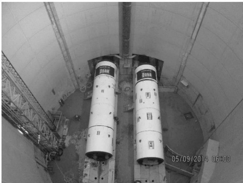
Abbildung 5: Aufbau der Vortriebsmaschinen im Schacht
