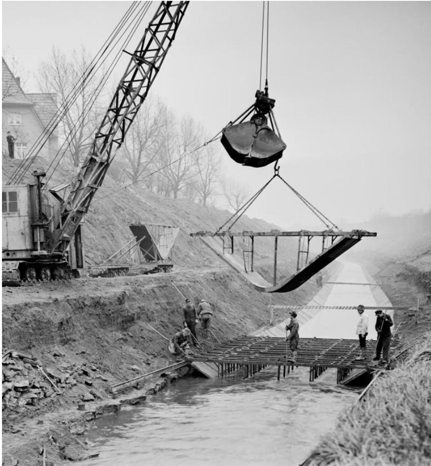
Abbildung 1: Historischer Bau des technischen Emschersystems (Quelle: EGLV)
